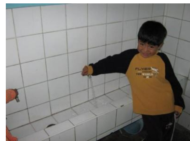
Die neue Wasserleitung
