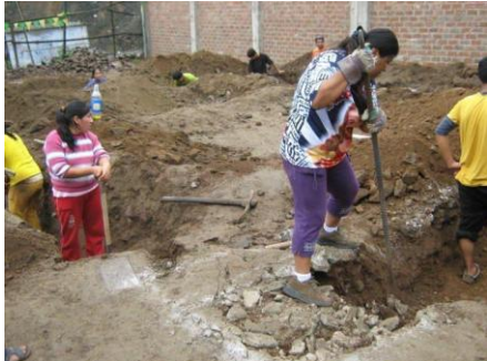
Anfangsphase des Baus
