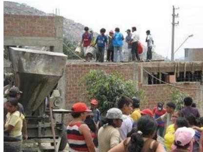
das Dach wird von Hand gegossen
